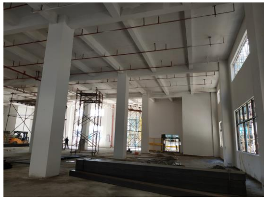
本项目现场照片
