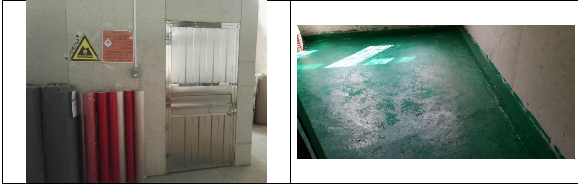
危险废物暂存场所
