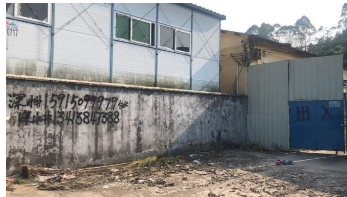
项目南面德润玻璃厂
